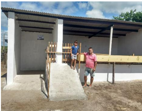
Estão em processo de construção 13 abrigos
